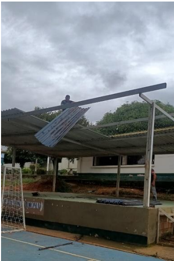
Construcción cubierta de la tarima Polideportivo Sede Jorge Eliécer
